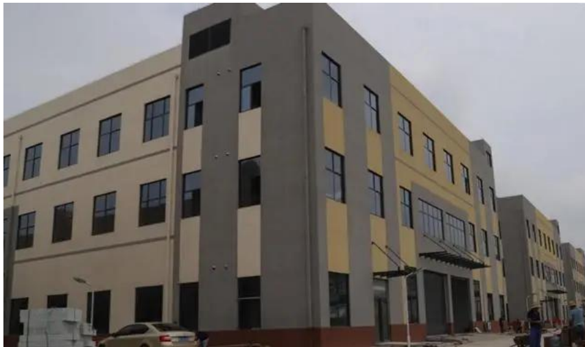
位于新港区、建筑面积 2.4 万平方米的岳阳 3D 打印产业基地项目
